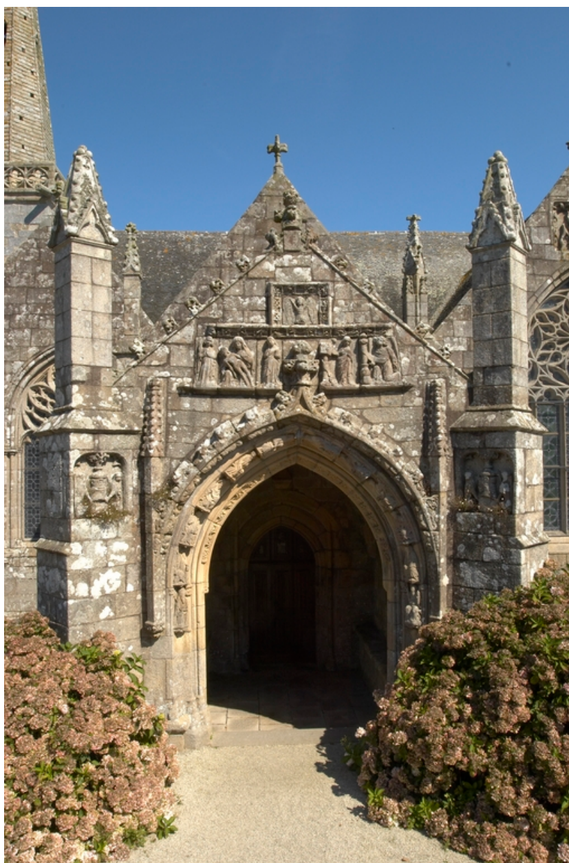
Porche sud, vue générale
