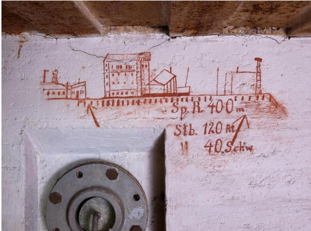
Vue du panorama de tir avec repère de distance pour la mitrailleuse. Au centre, on reconnaît le bâtiment frigorifique dit la glacière de Lorient. Sous le dessin, bouche de surpression à clapet
