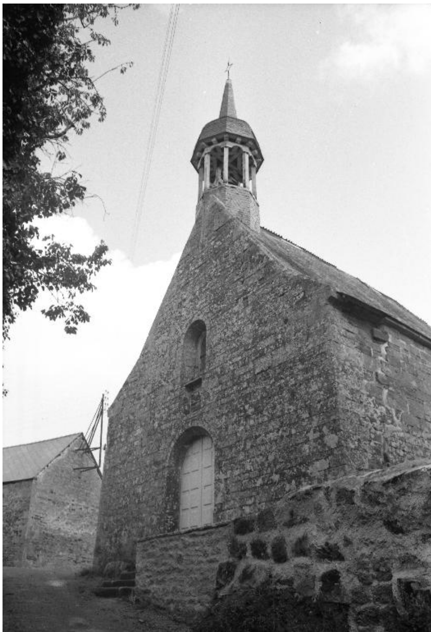
Vue d'ensemble de la façade ouest.
