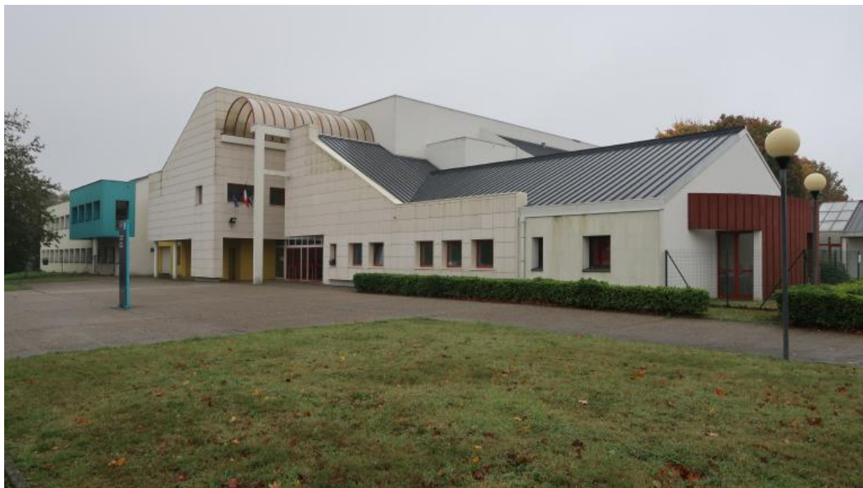
Façade nord : de gauche à droite : le bâtiment A (externat scientifique), l'entrée et le bâtiment D (administration).
