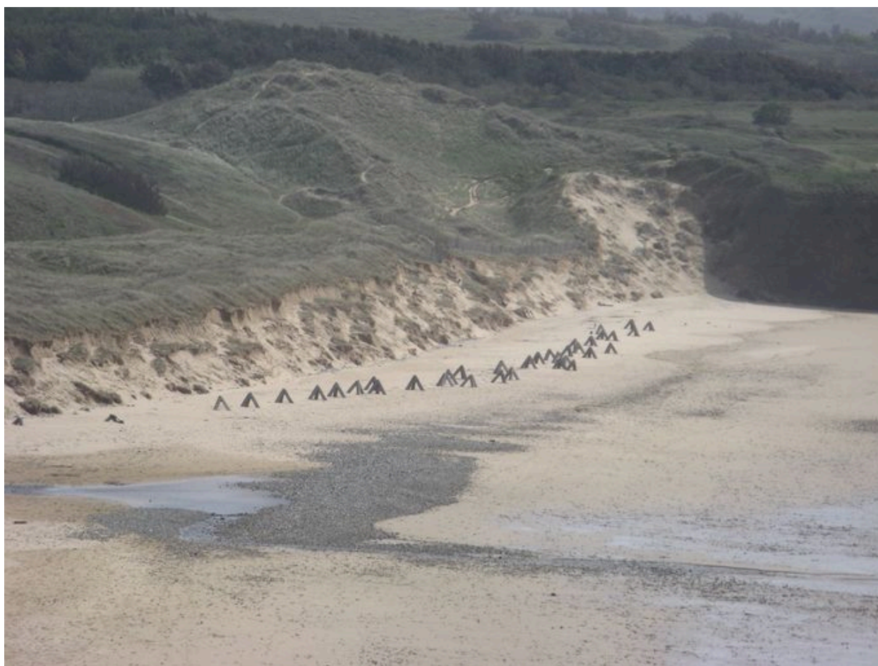
Vue générale de l'ensemble fortifié de la plage de la Palue (obstacles de plage et pointe de Kerdra)
