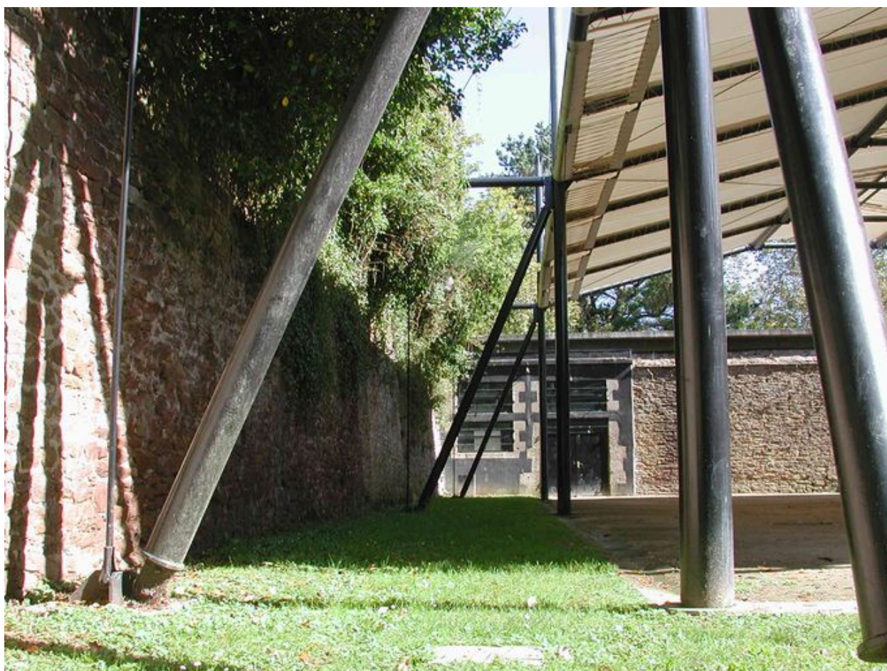
Vue du fort du Dellec : structure légère et toile assurant l'étanchéité de l'espace de la caserne aujourd'hui réhabilité
