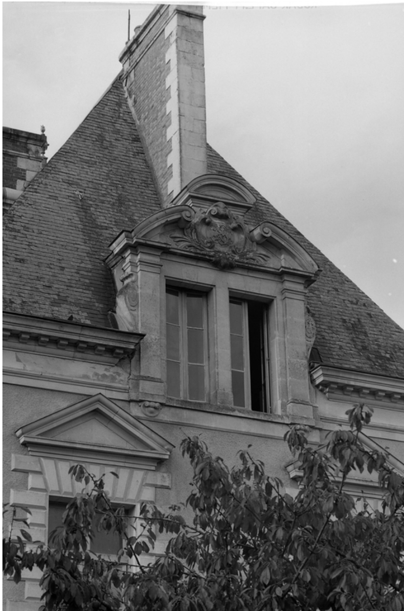
Face est : détail de la lucarne.
