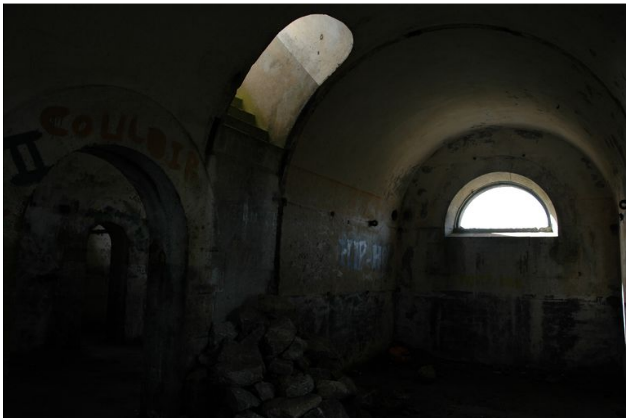
Vue du réduit de batterie de côte de Loqueltas, casernements et magasin aux vivres, accès à la terrasse
