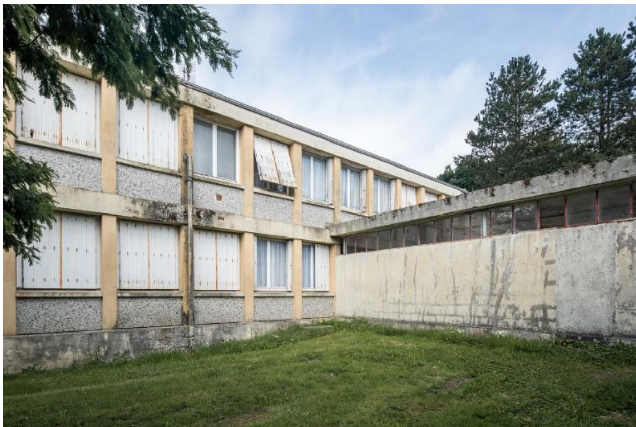
Façade est et galerie de liaison entre l'infirmierie et le service de restauration.
