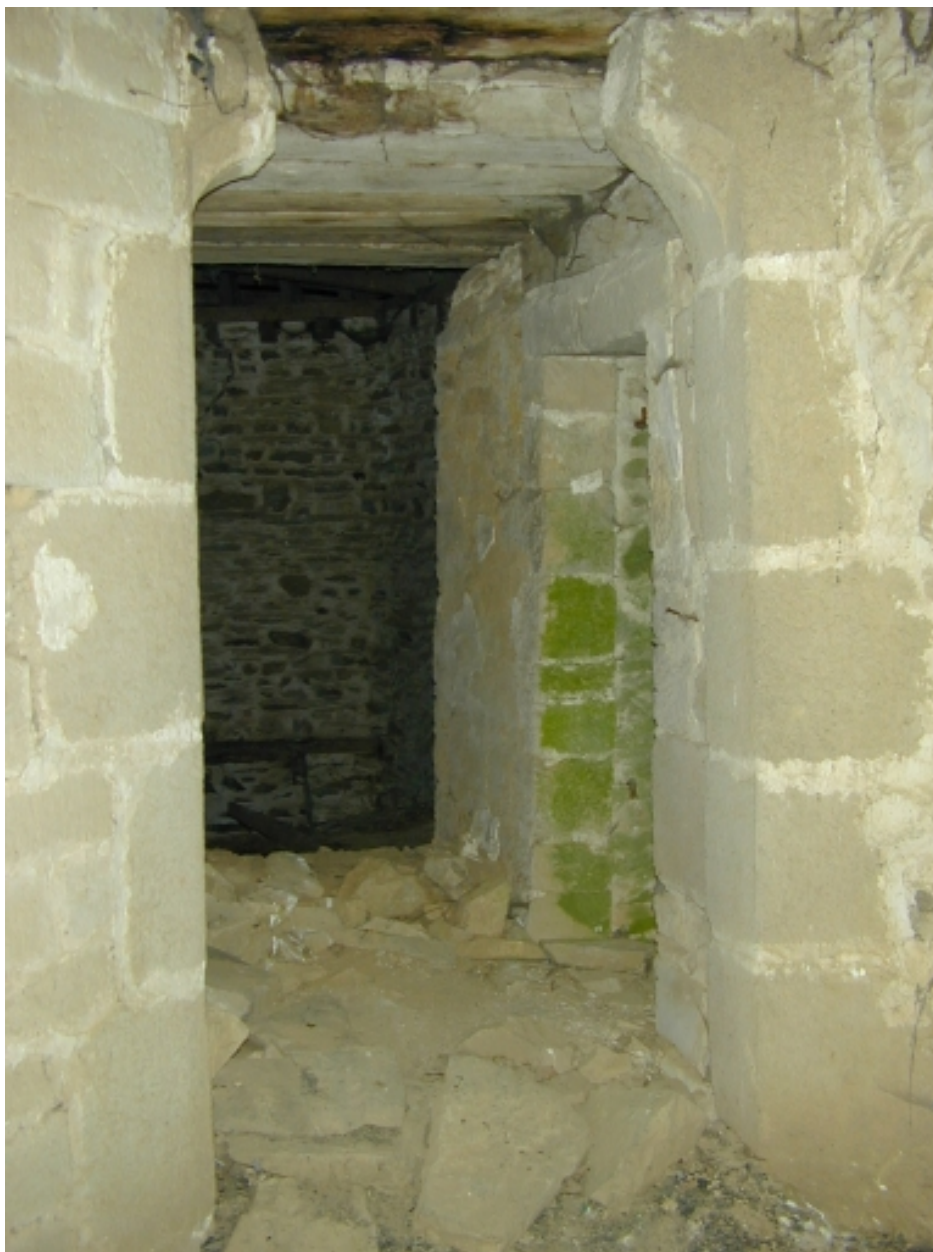
Intérieur, étage de comble, couloir des latrines
