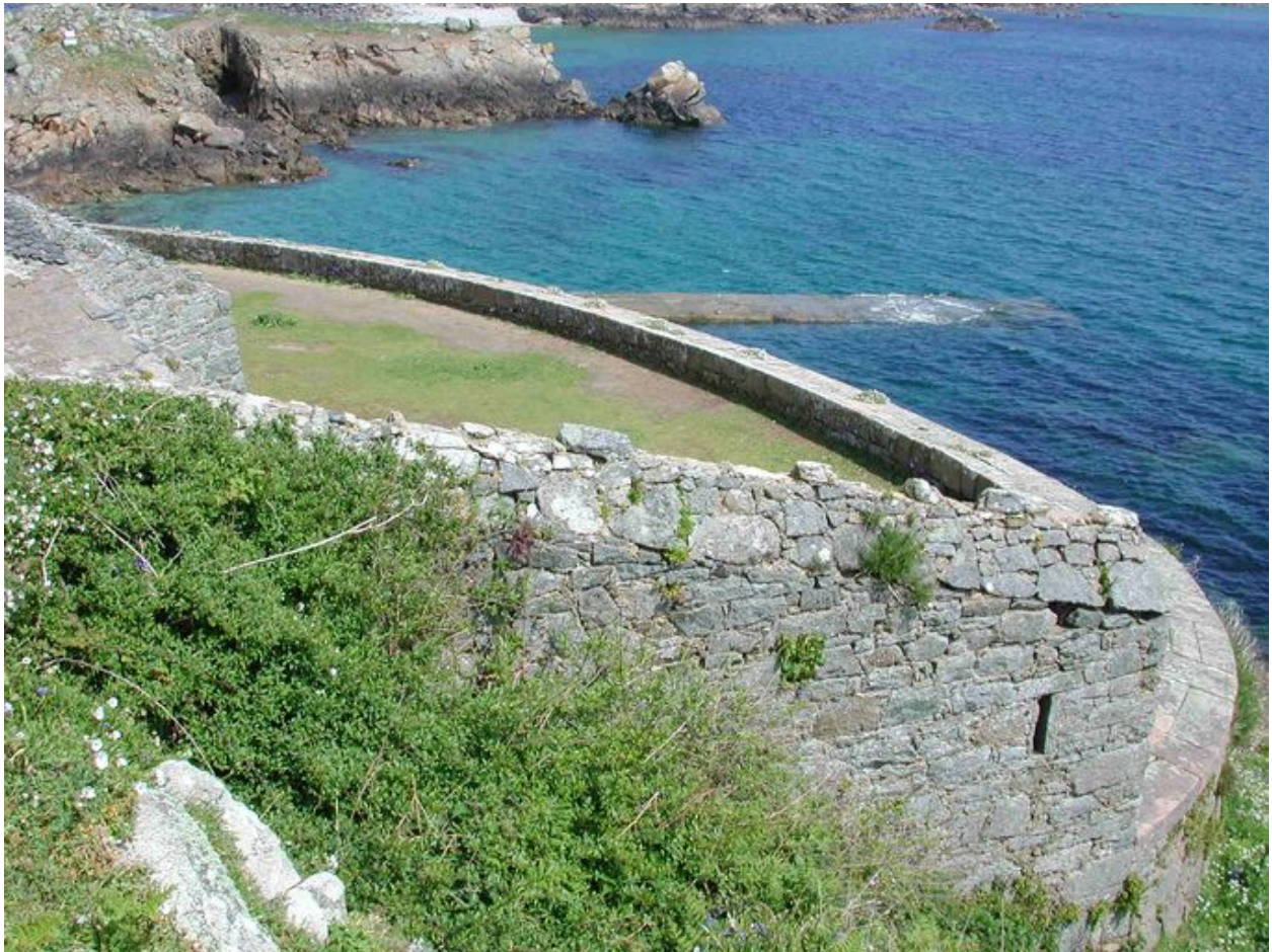
Vue du mur défensif crénelé protégeant la batterie d'une attaque par le sud (état en 2002)
