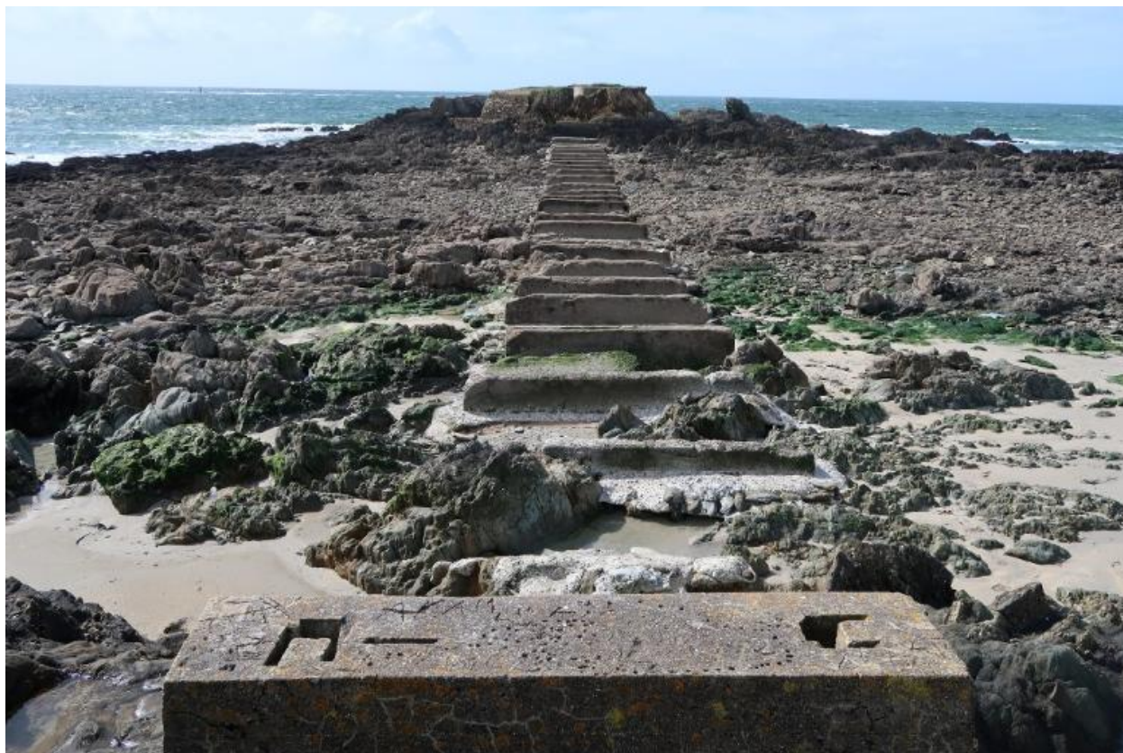
Vue des vestiges de la passerelle
