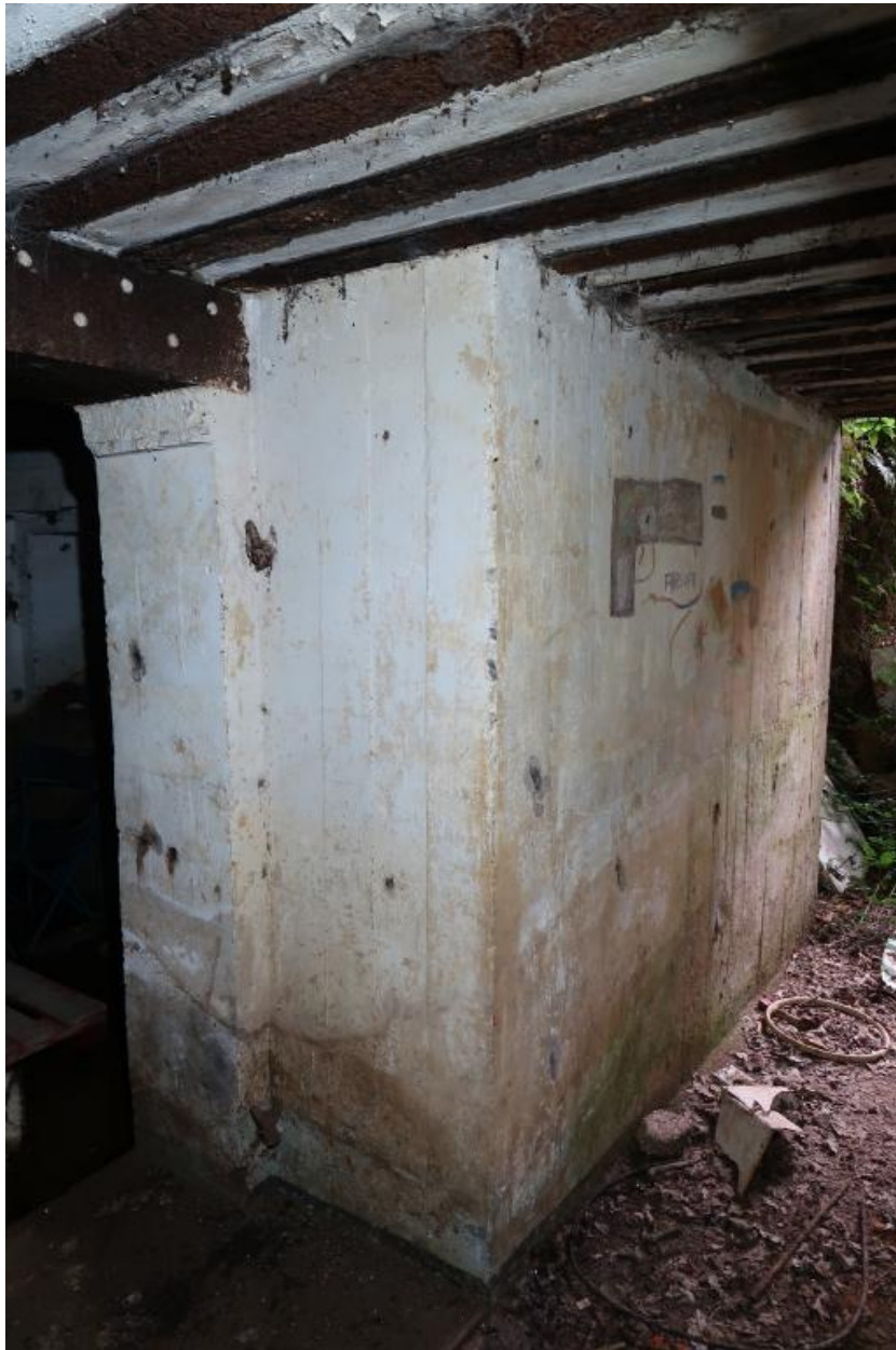
Vue du mur de refend situé entre le couloir d'accès et la pièce de vie - chambre de troupe (état en 2021)
