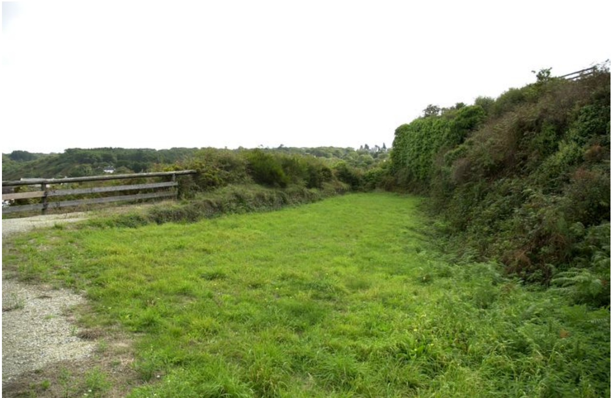
Vue du fort de Lanvéoc : batterie
