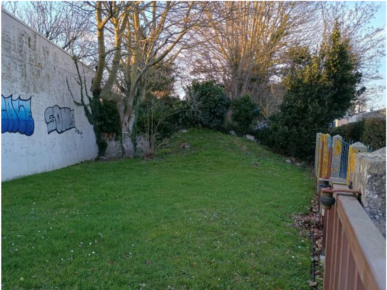
Vue de l'extrémité sud de la digue dans la parcelle section CA, n° 572 depuis le chemin des Amoureux
