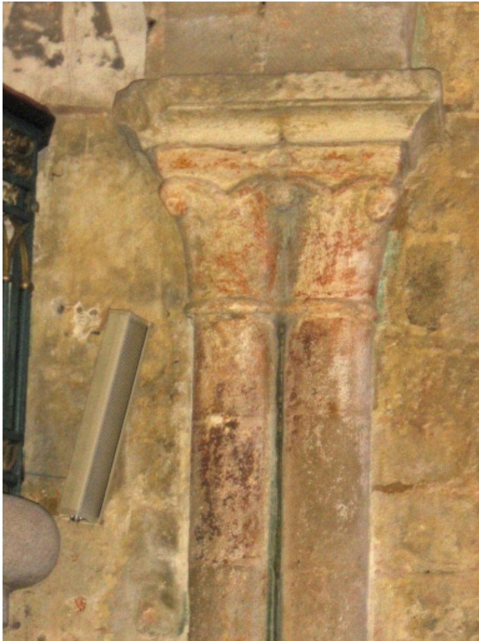
Elévation intérieure Sud : détail des colonettes du registre inférieur
