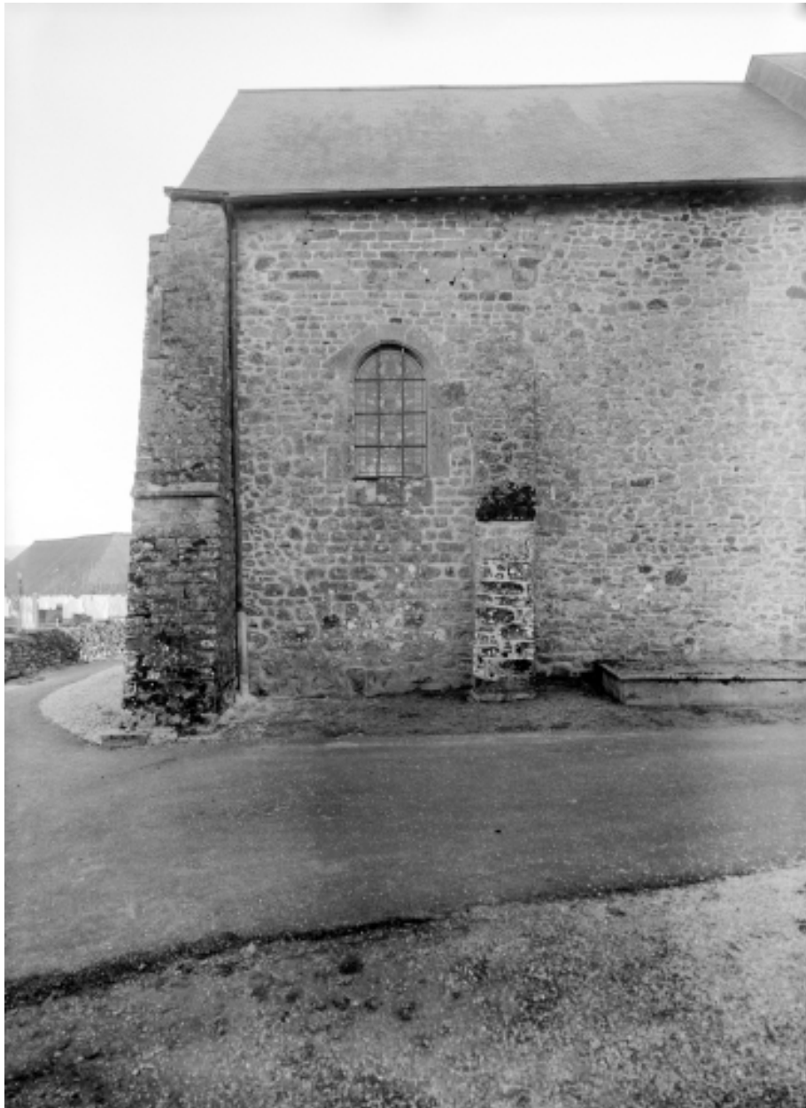
Elévation nord, partie est : vue générale
