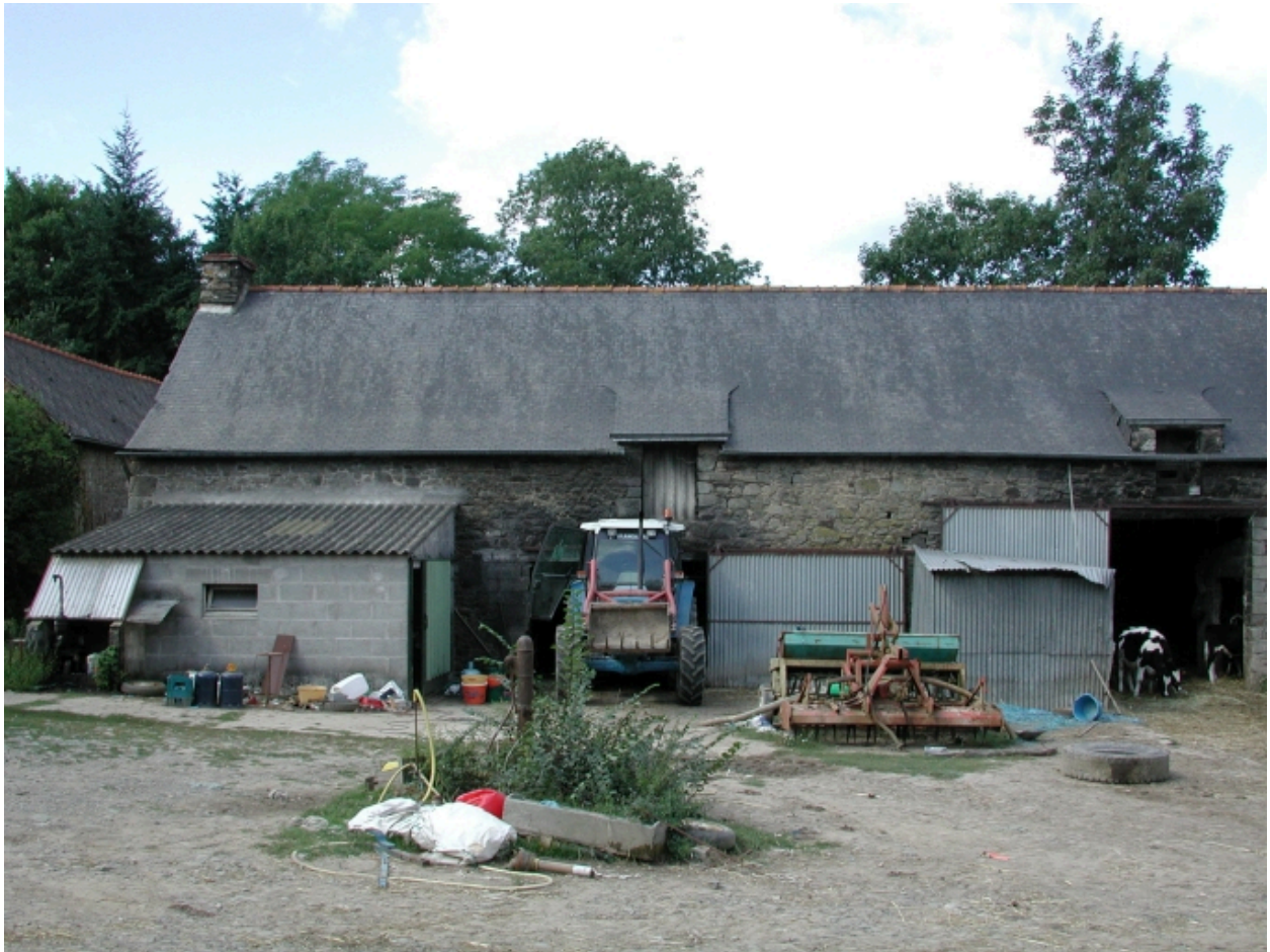
La ferme : ancien alignement de logis, vue générale est
