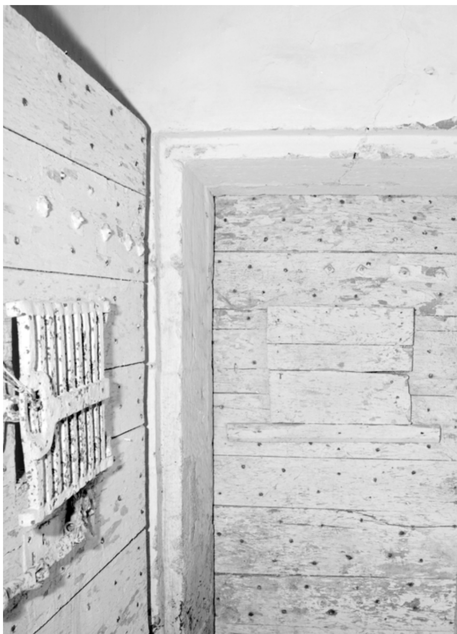
Cachot du rez-de-chaussée sud, détail de profil de la porte ouverte.
