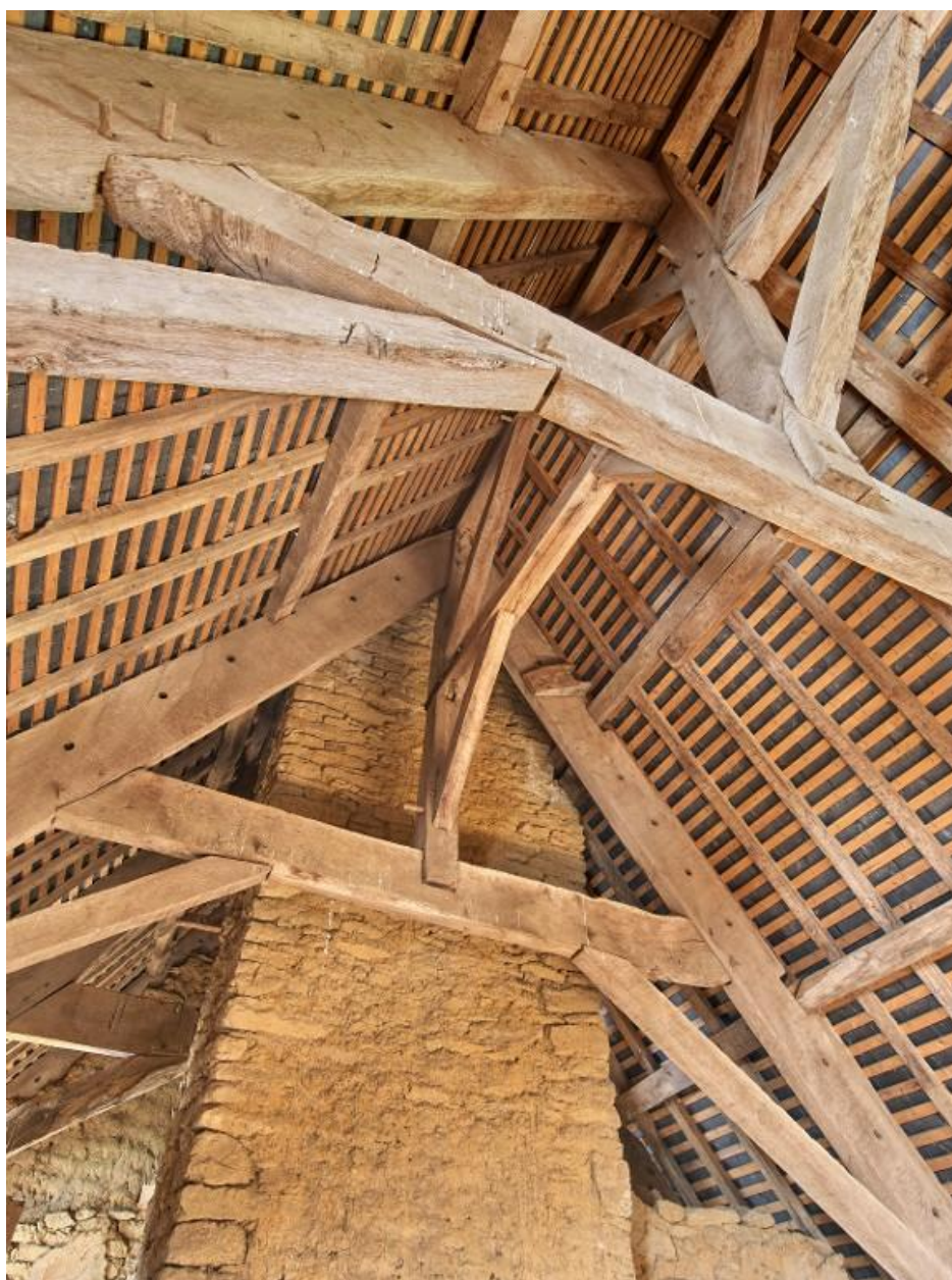
Charpente avec contreventements sur les fermes
