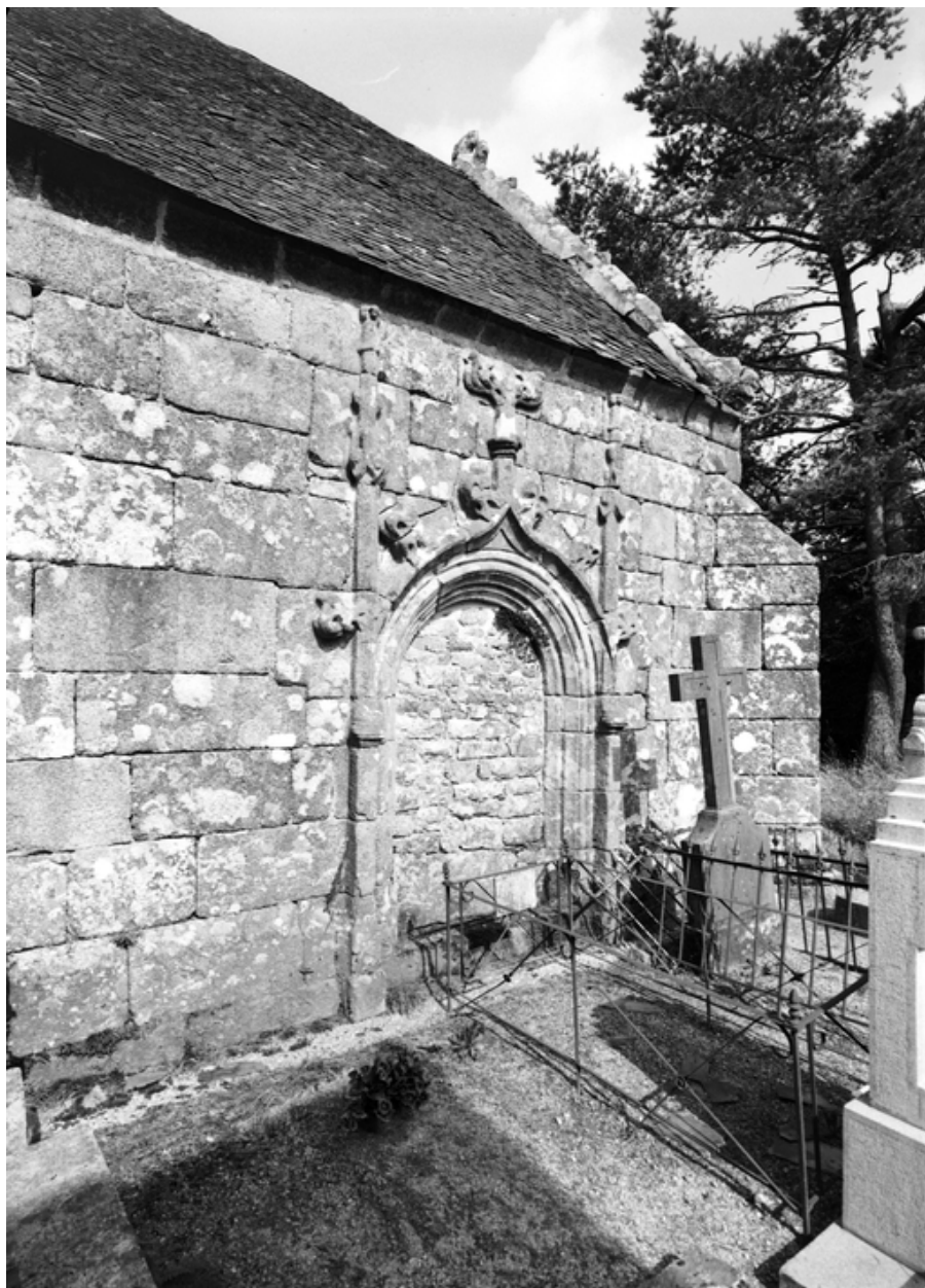
Porte, mur ouest du bras sud du transept
