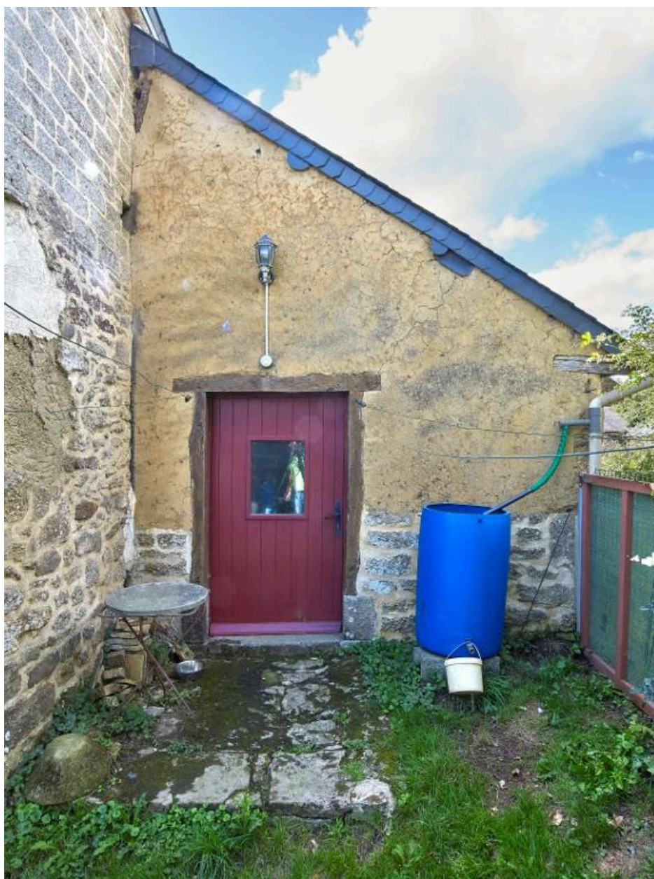
Cellier en terre enduit accolé au mur nord
