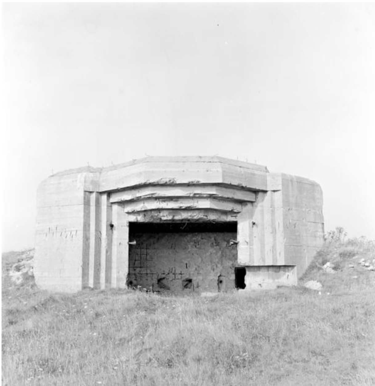
Vue frontale de l'un des trois bunkers - casemates pour canon de 164,7 mm en 1969 (le quatrième bunker a été détruit en 1944 par une explosion)
