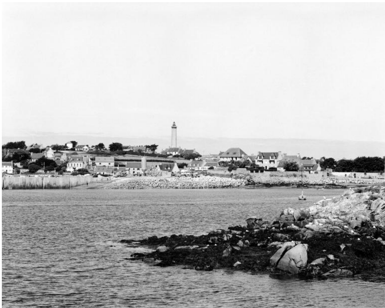
Travaux murs de soutènement à droite de la cale de Vil vihan (1986)
