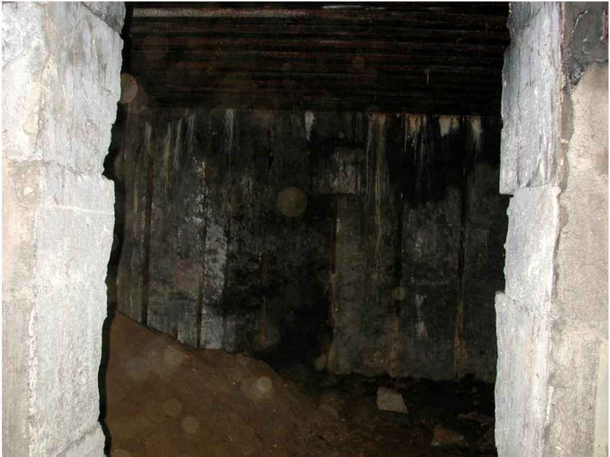
Vue de la salle de garde. Elle a brûlé
