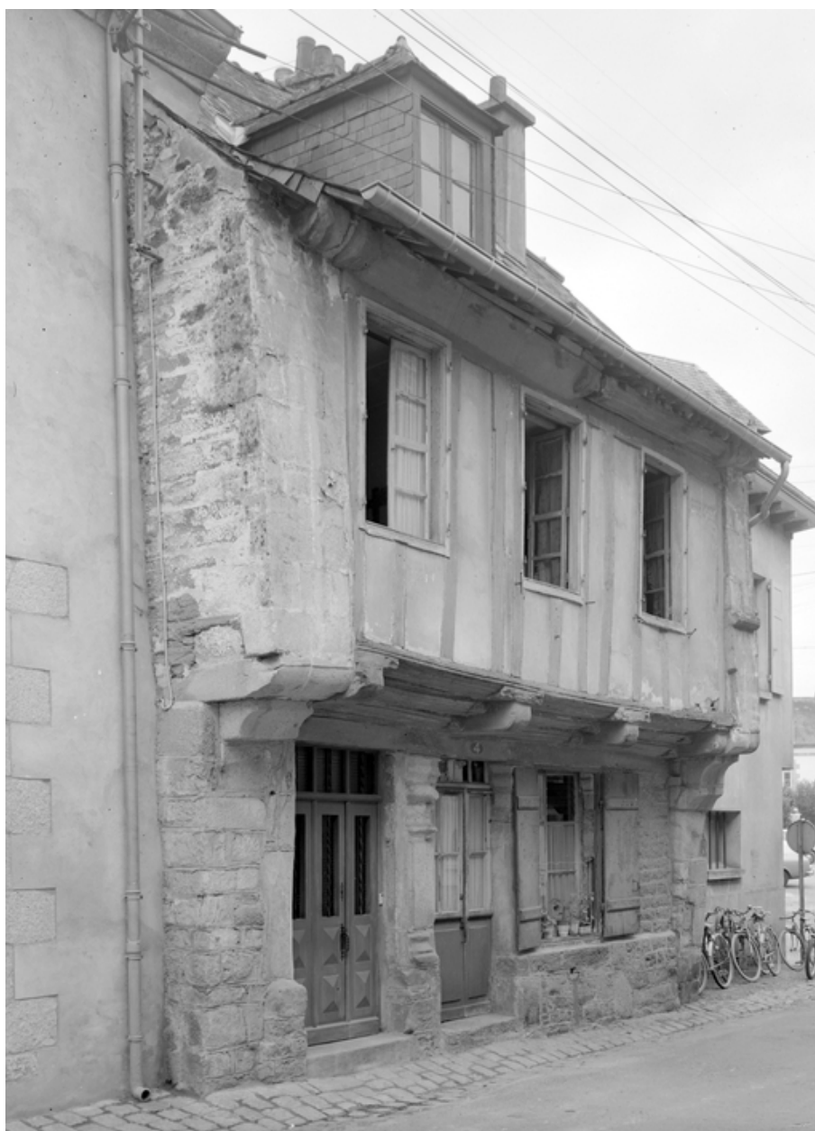
Vue d'ensemble de la façade nord-est.
