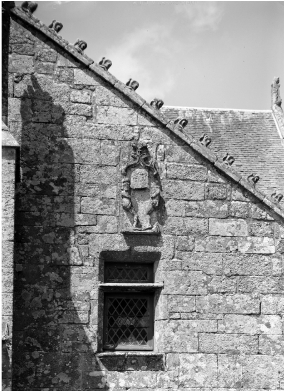
Sacristie, face est, fenêtre du premier étage.
