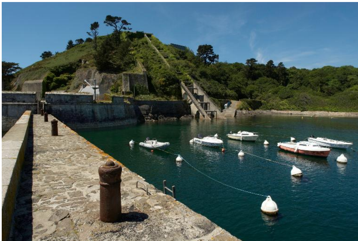
Plouzané : vue du fort du Mengant, môle construit en 1877 dans l'anse
