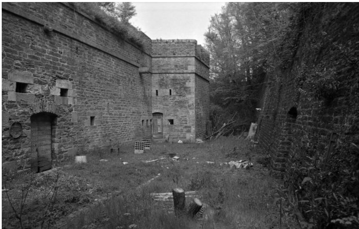
Le Palais, enceinte urbaine, réduit A, façade bastionnée, état dans les années 1970.
