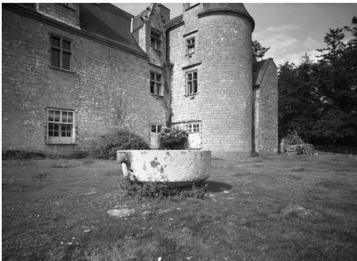
Cour sud : vue sud ouest du bassin
