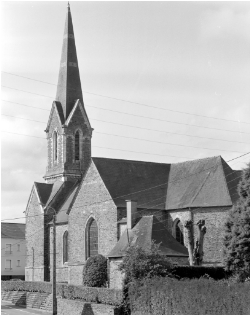
Elévation Est : vue générale
