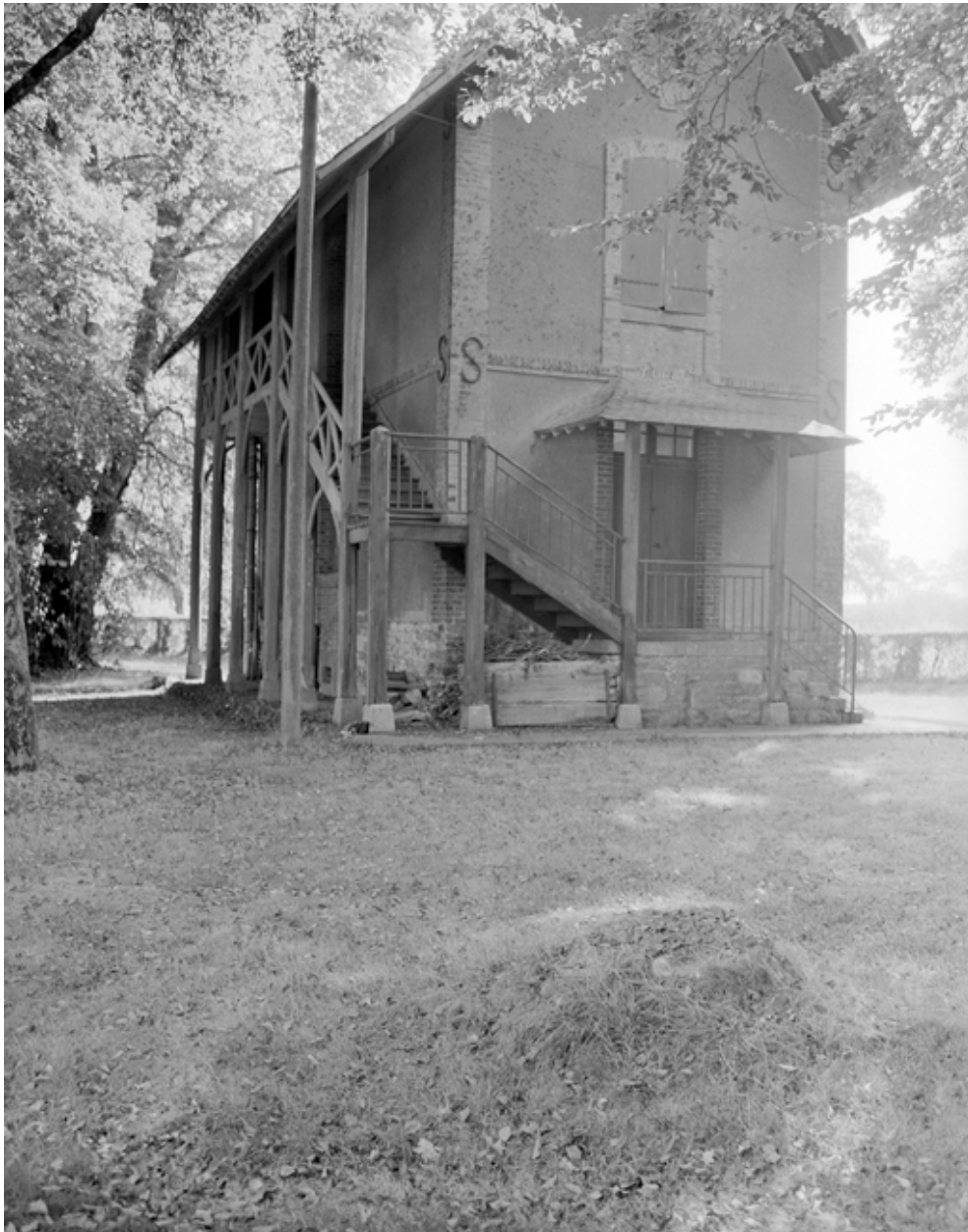
Conciergerie, vue générale nord.
