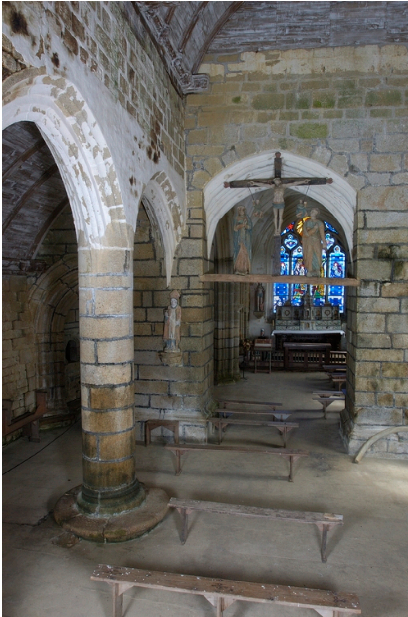
Intérieur, vue depuis la nef vers le choeur
