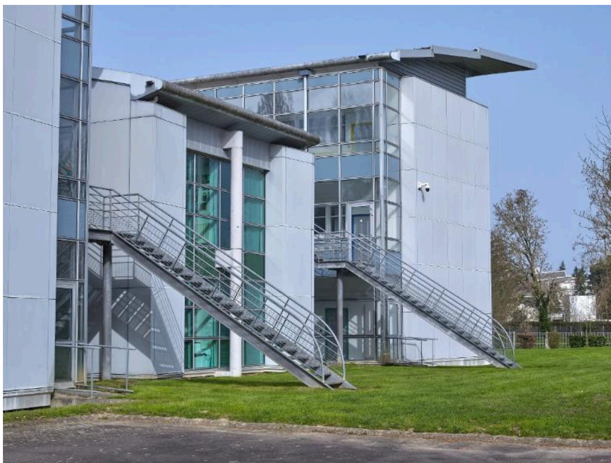
Façade est du bâtiment principal. Joël Y. Gautier, architecte, 1992.
