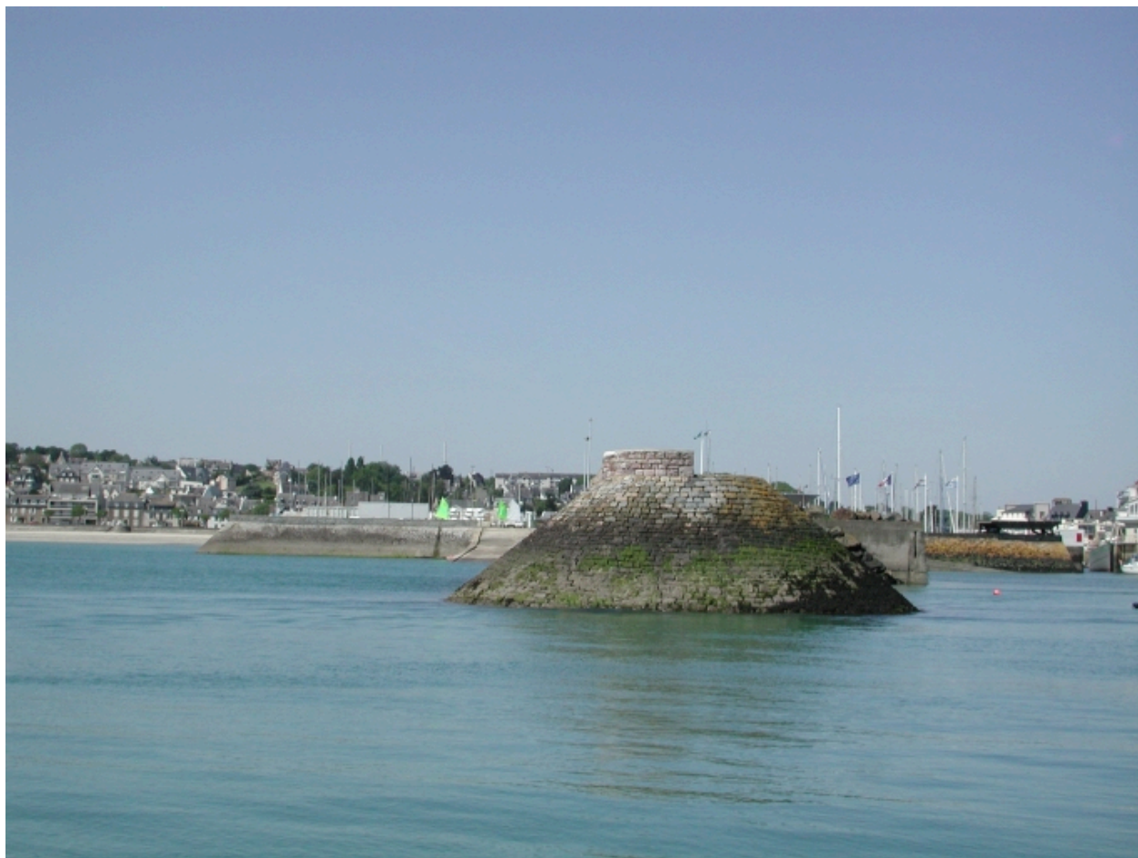
Vue de la jetée de Pordic du côté Est et du musoir
