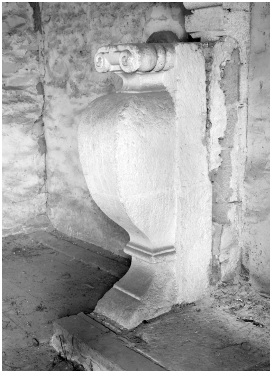
Corps de logis : détail de la cheminée de la 2e salle du 1er étage
