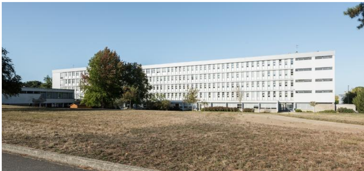
Bâtiment G, internat, façade est, vue d'ensemble. A gauche, bâtiment H, infirmerie : façade nord. Louis Arretche et Jean Monge, architectes, plans 1959.
