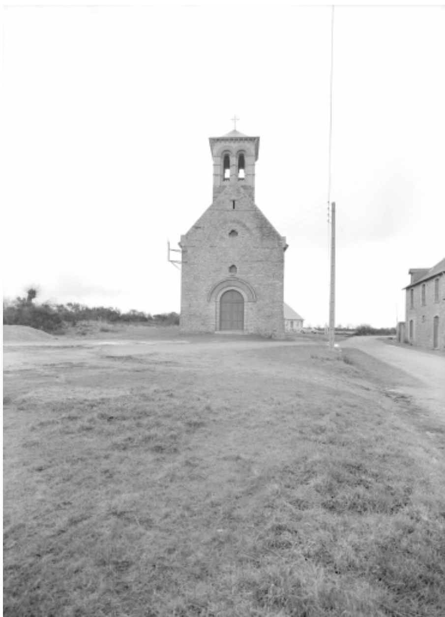
Elévation Ouest : vue générale
