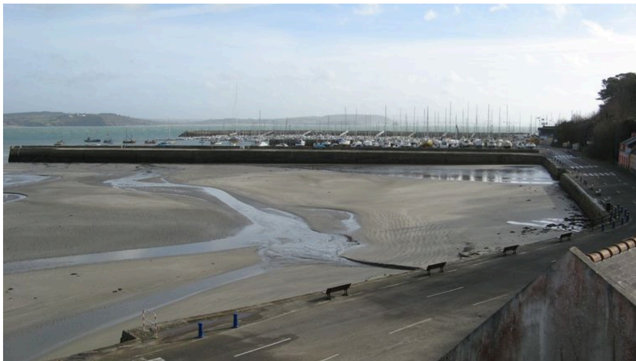
Vue générale du môle
