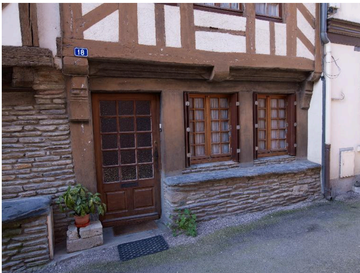
Rez-de-chaussée (état en 2012)
