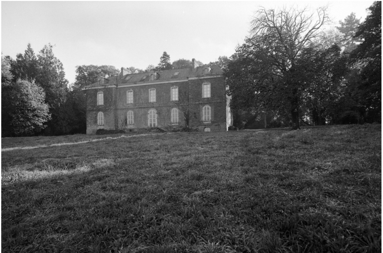
Façade nord, vue générale.
