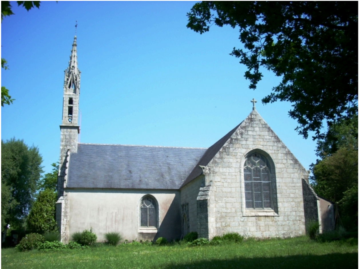
Clohars-Fouesnant, chapelle du Drennec : vue générale sud
