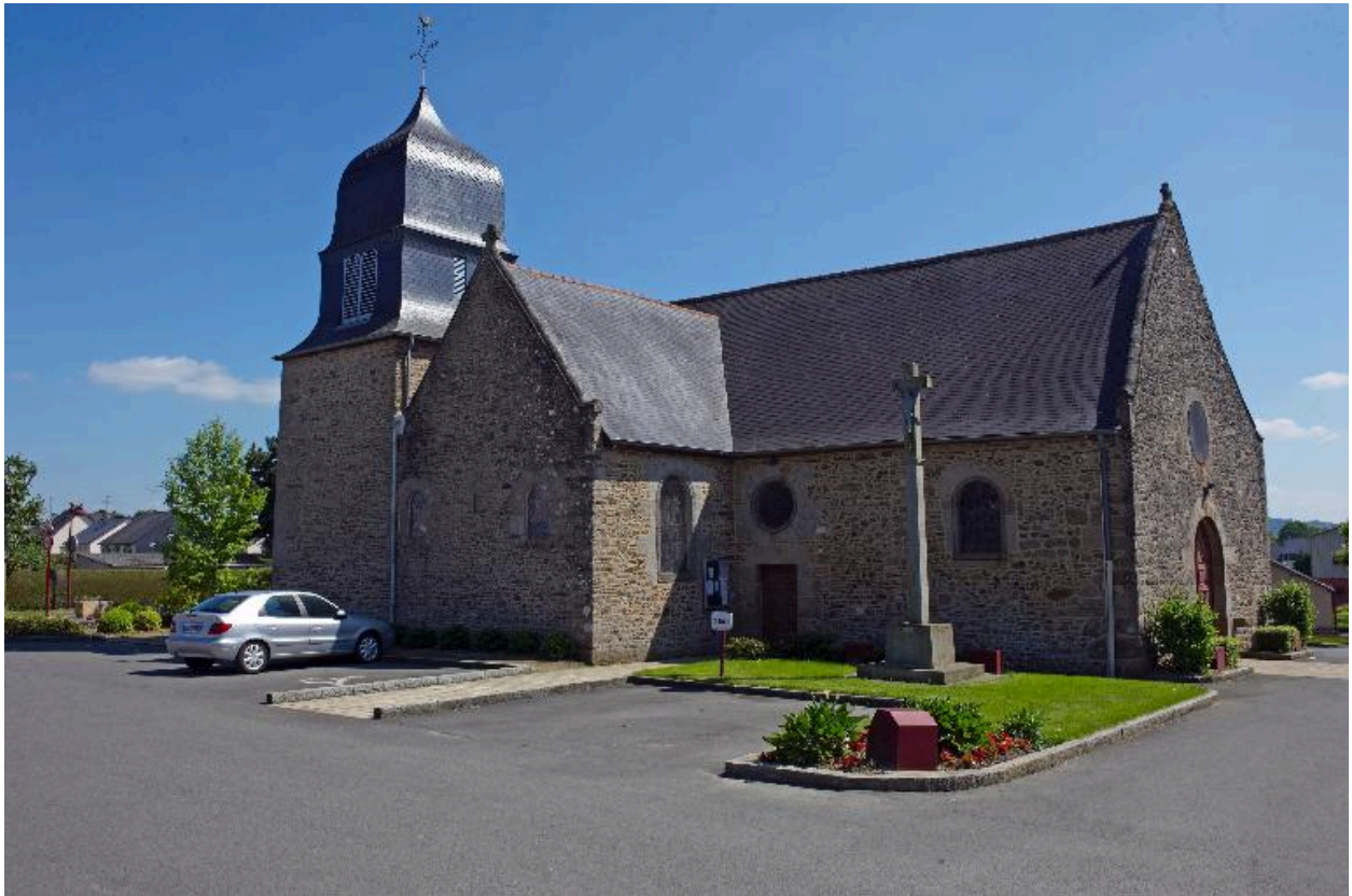
Vue générale : côté nord-ouest
