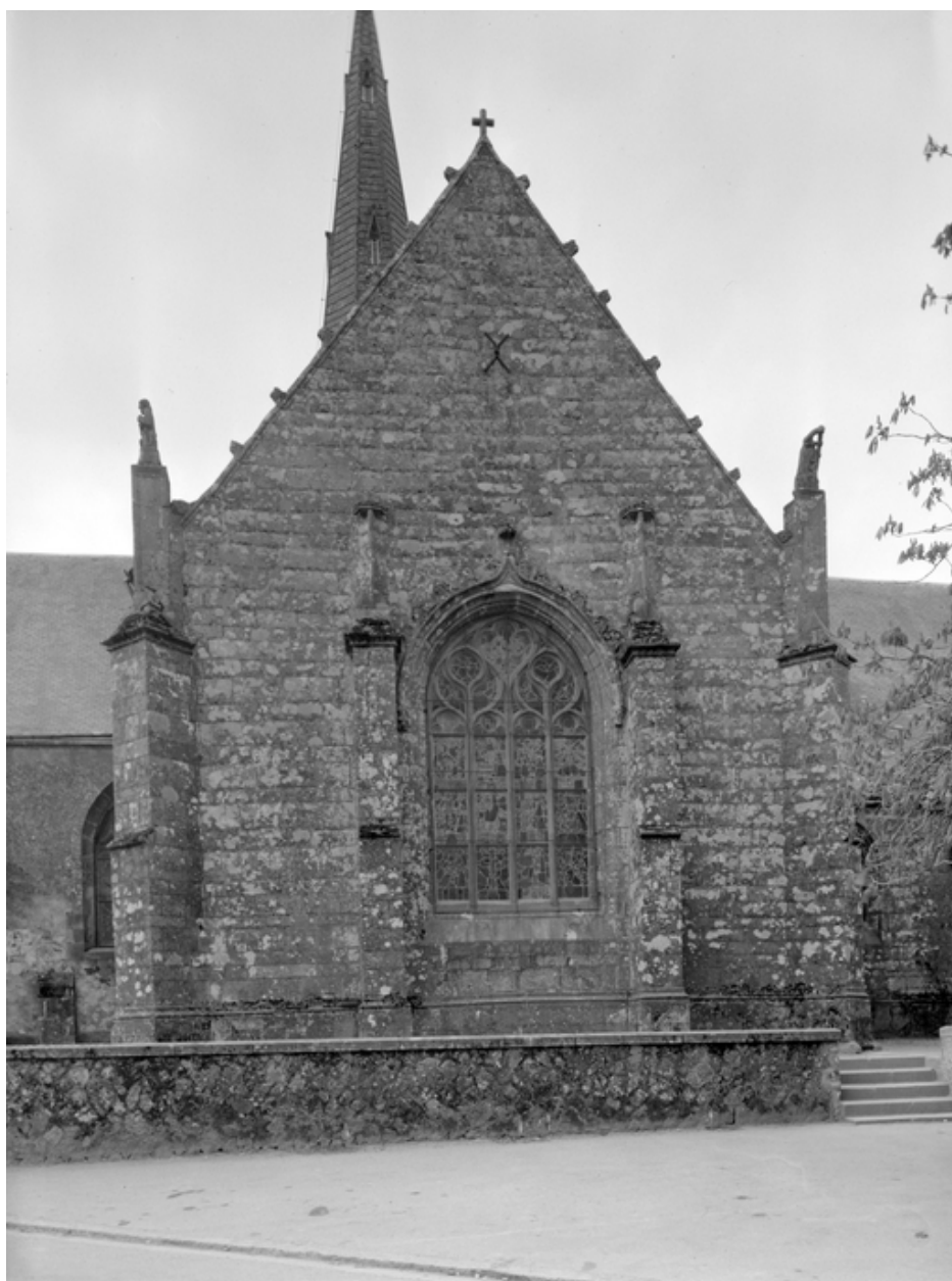
Mur nord du bras nord du transept.
