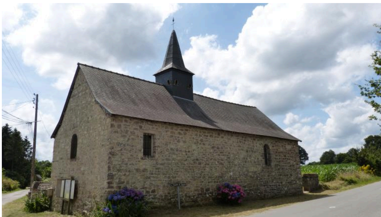
Vue générale nord-est en 2018
