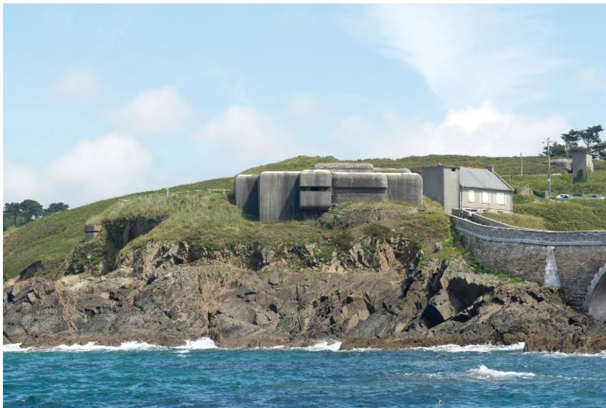
Vue de la pointe du Petit Minou depuis la mer (extrémité sud) : bunker - poste de commandement, logement et transformateur électrique
