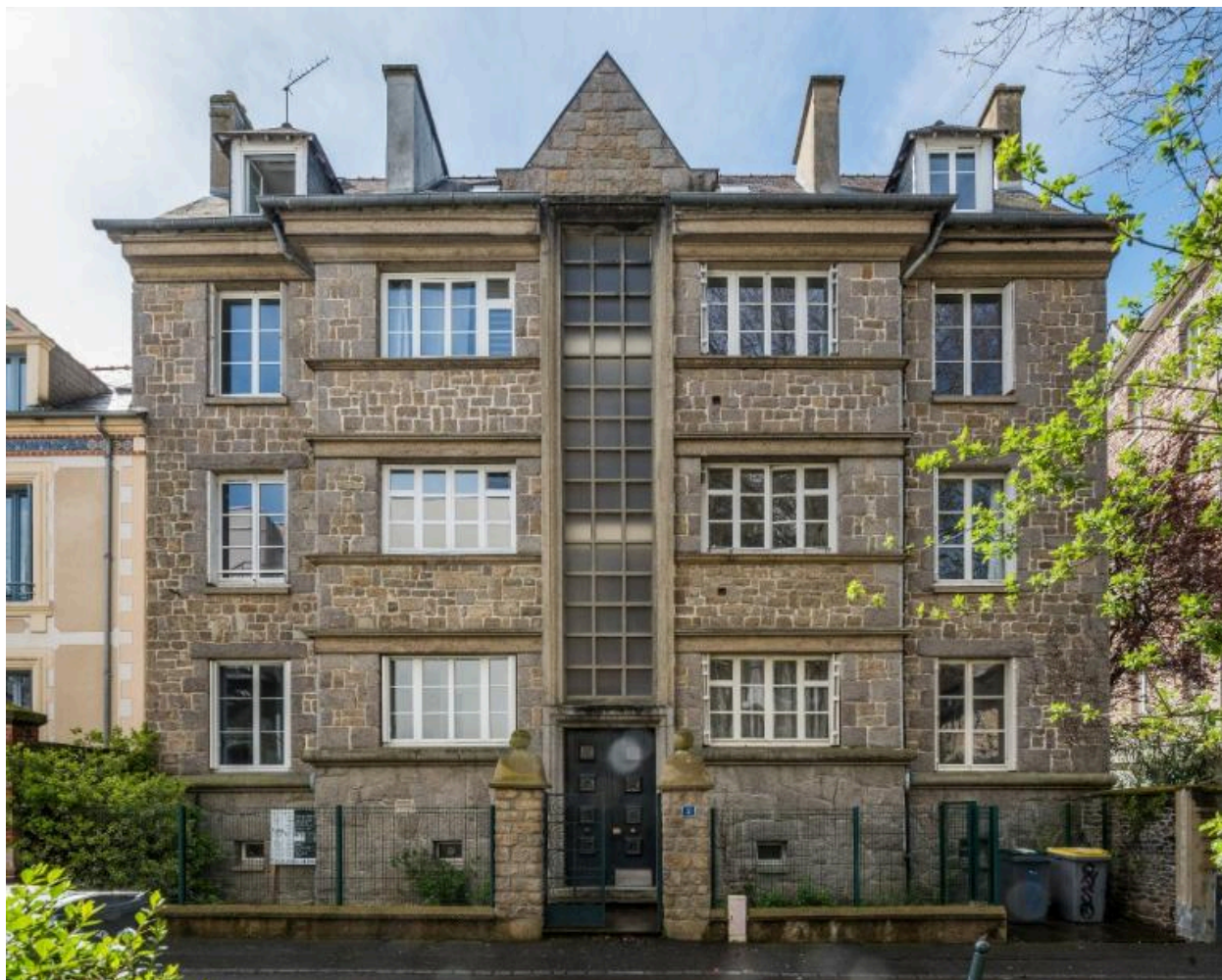
Vue générale de l'élévation antérieure.
