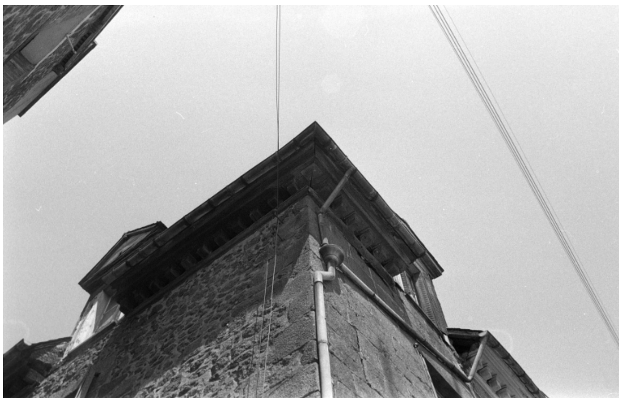
Détail de la corniche
