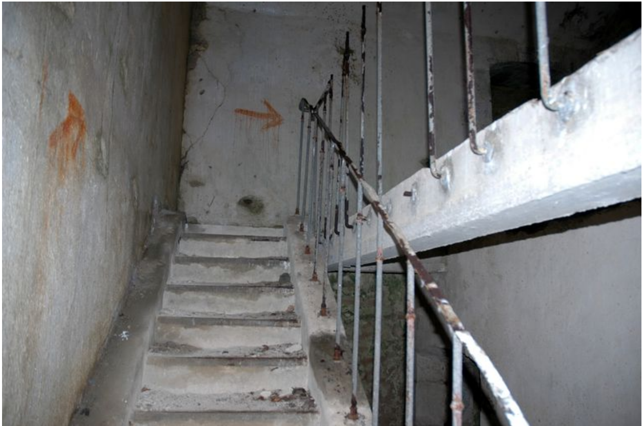
Vue de la caserne défensive Robert : escaliers (béton) desservant l'étage
