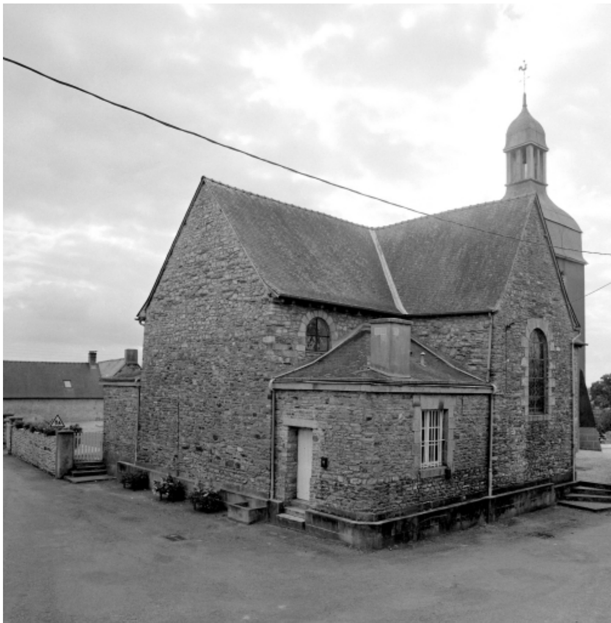
Elévation Nord-Est : vue générale
